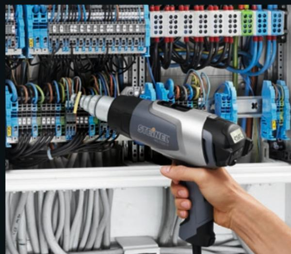
Rétracter des câbles dans une armoire de distribution.
