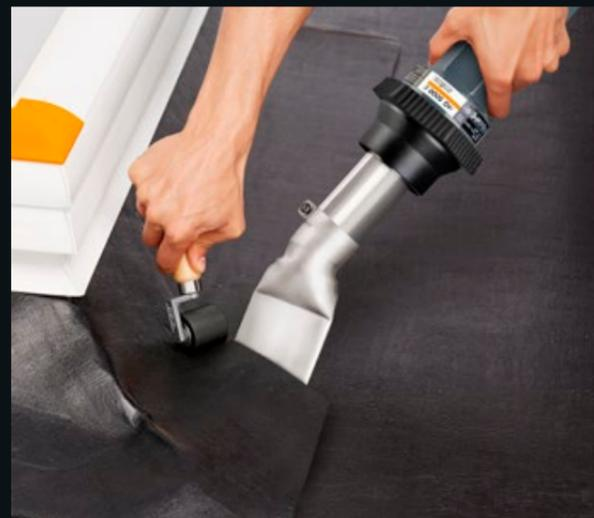
Soudage par recouvrement pour une fenêtre de toit.
