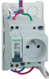
Installation d'une prise de courant
